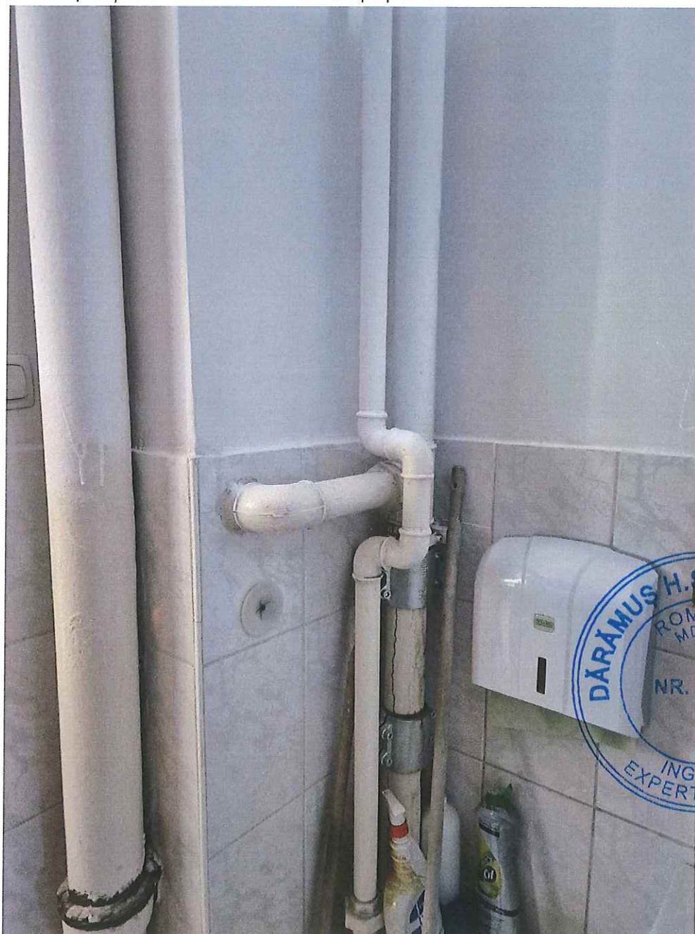
Figura 1: Reparații la conductele interioare de apă potabilă:
